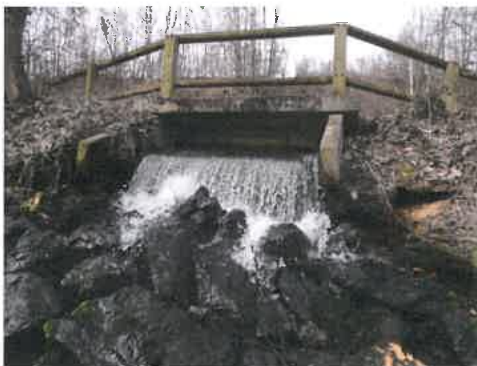
Lieu de rejet des eaux traitées : L'Orne
